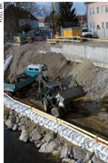
Bis Ende April werden die Bauarbeiten fertiggestellt.
