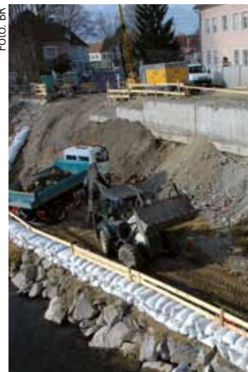
Bis Ende April werden die Bauarbeiten fertiggestellt.
