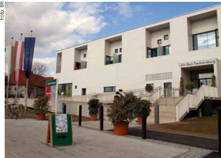
Das LKH Bad Radkersburg ist mit hohem Investitionsaufwand umgebaut bzw. erweitert worden.
