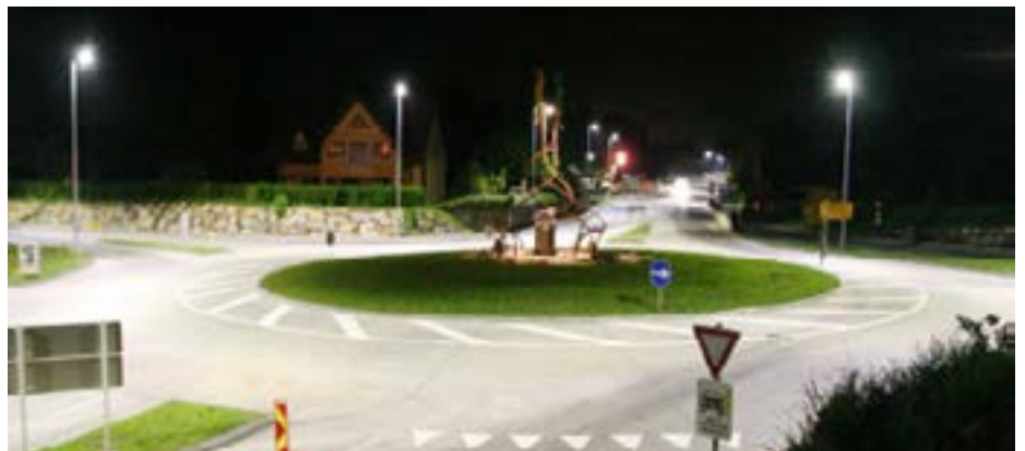
Beispiel Kreisverkehr mit LED Leuchten
