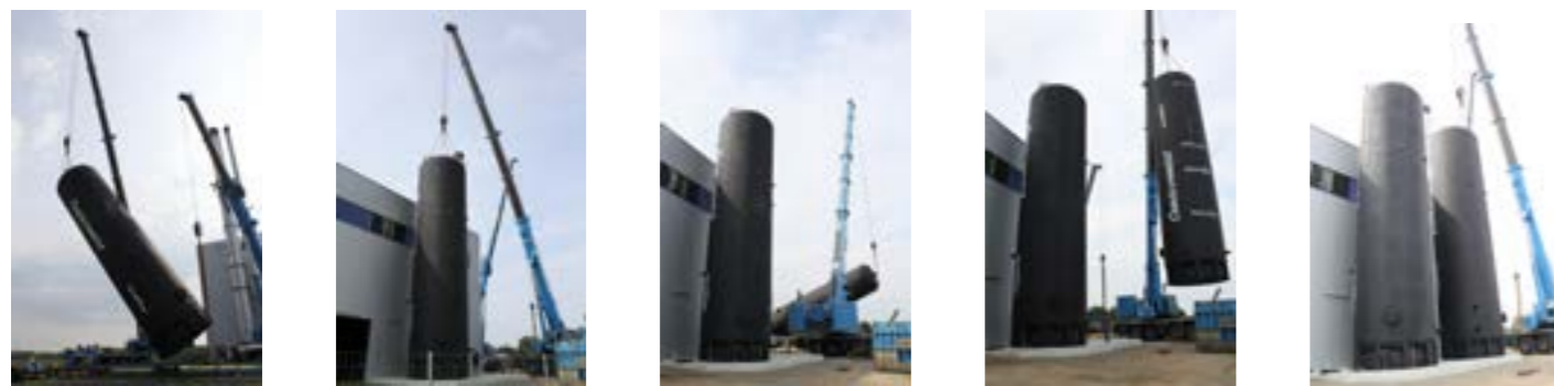
Beim Platzieren der Energiespeicher wurden einige Tonnen Stahl bewegt.
