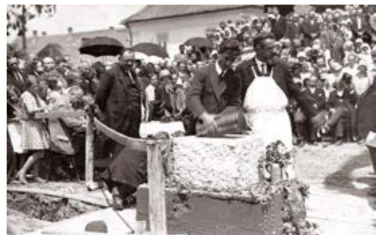
Grundsteinlegung der Christuskirche, 15.6.1930. MiaZ
