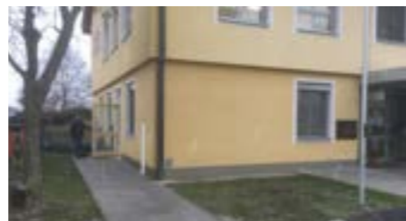
Neuer Eingang in die Bürgerservicestelle Zeltlingerstraße. Der ehemalige Eingang in die Bürgerservicestelle gehört jetzt zur Kinderkrippe.
